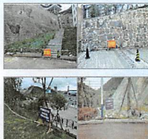
图为对校园及周边可能存在安全隐患采取临时措施
